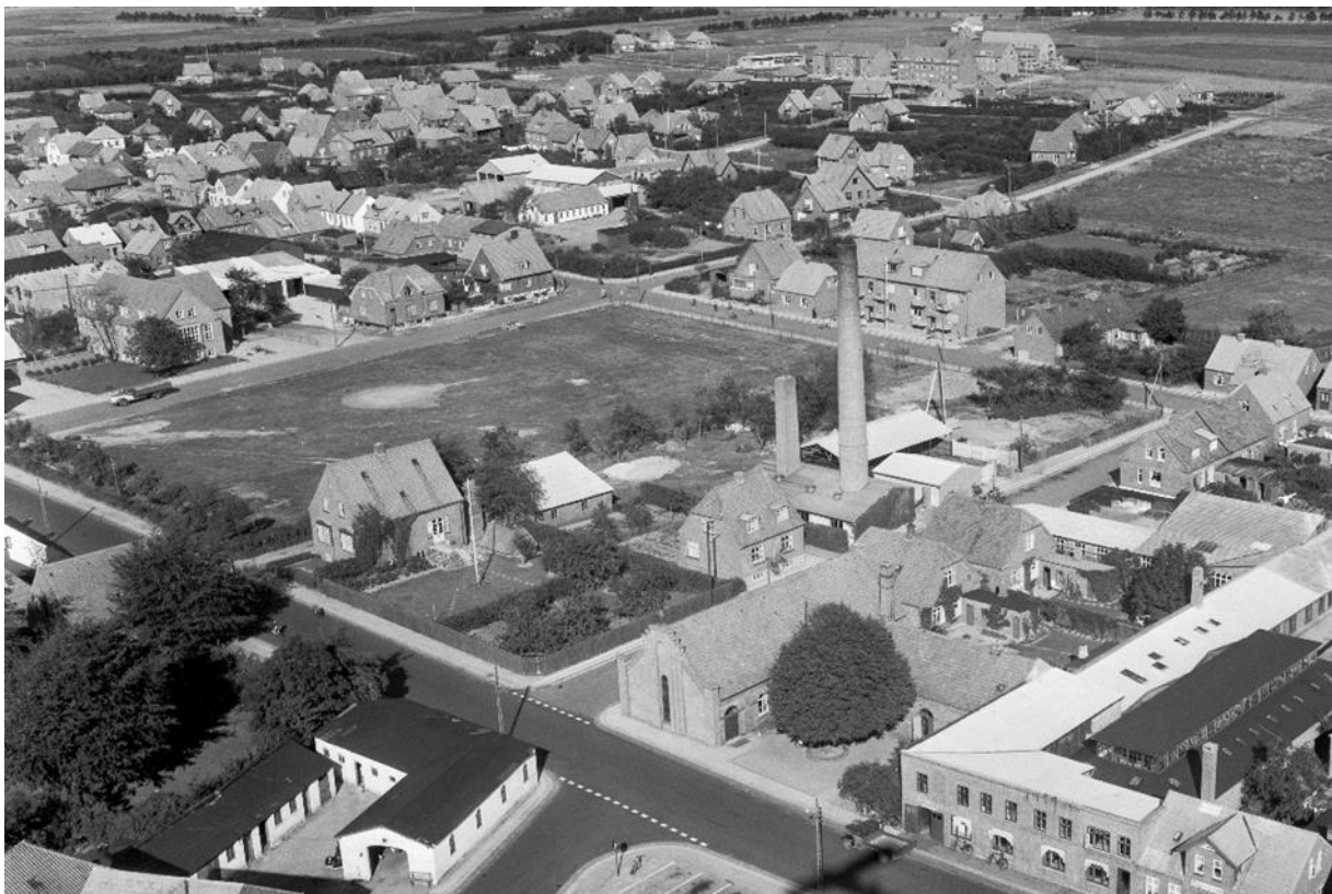
Foto: Sylvest Jensen, Det Kongelige Bibliotek, 1956. Skjern Fjernvarmecentral på Kjærs Allé i 1956. Vandværket er ikke bygget endnu.
